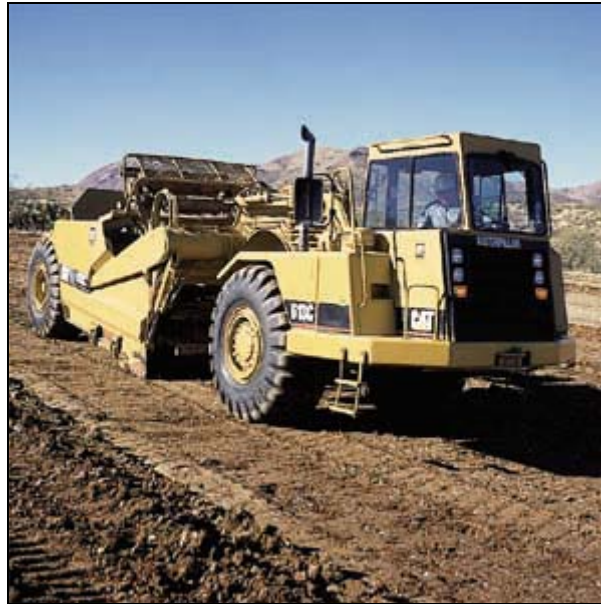
Fig. 3. Relleno efectuado con moto-trailla.
